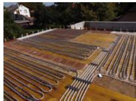
Izgled sustava SLAB-16 po završetku ugradnje
