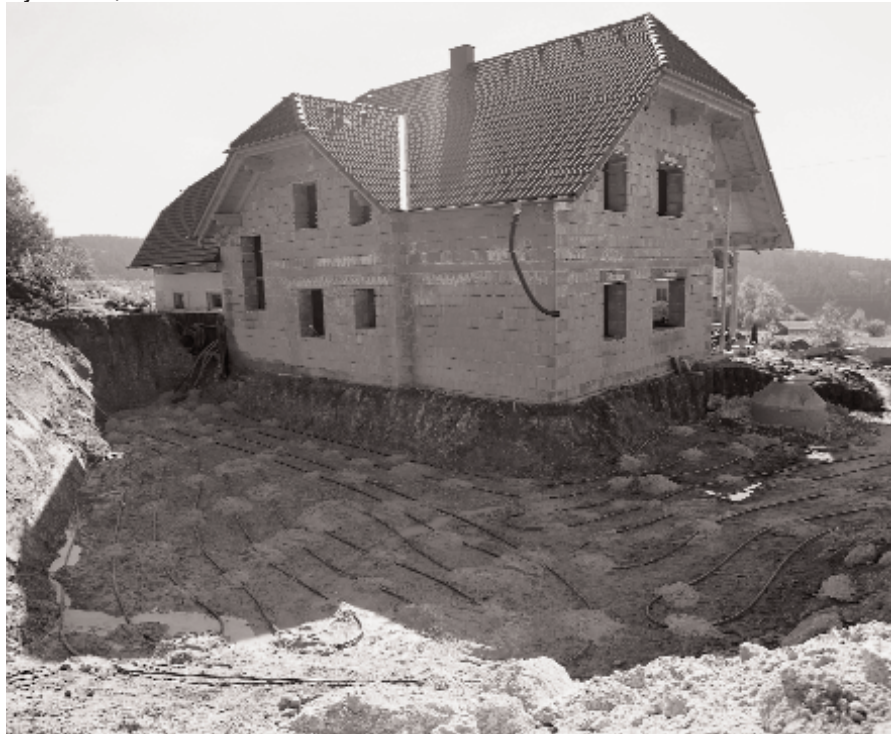
Pipelife površinski geotermički kolektor
