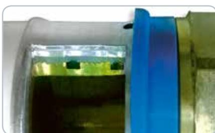
Poprečni presjek prešanog spoja
